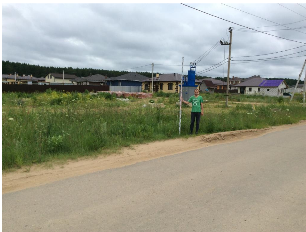
Рис. 11. Схема расположения объекта «Здание кафе-бистро расположенное по адресу: г. Калуга, д. Черносвитино», ул. Черносвитинская. Вид с юго-востока.
